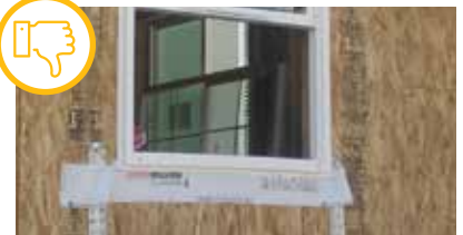
Ventana con tapajunta instalada inapropiadamente.
