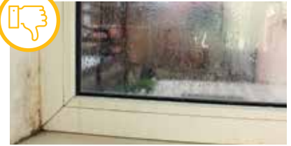
Ventana con condensación por falta de aislamiento.
