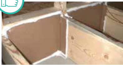
Vigas del piso debajo de muro bajo (bloqueadas con material rígido y selladas con masilla).
