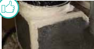
Pleno sobre el cielorraso sellado con masilla selladora de ductos incrustada en fibra a base de agua.
