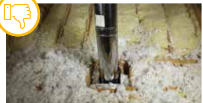
Penetración sin sello (dispositivos que emiten calor).
