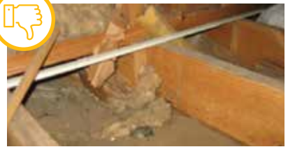
Vigas del piso debajo de muro bajo (sin bloqueo con material rígido y sin sello).
