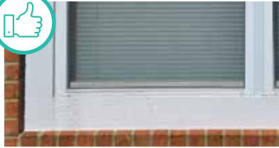
Ventana de doble panel, instalada con tapajuntas adecuado.
