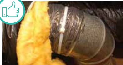
El ducto flexible está bien sujeto al ducto de metal.
