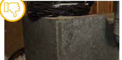
Ducto de pleno sobre cieloraso sin sellar.
