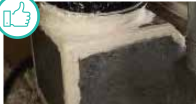
Pleno sobre el cieloraso sellado con masilla selladora de ductos incrustada en fibra a base de agua.
