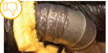
El ducto flexible no está mecánicamente sujeto al ducto de metal.
