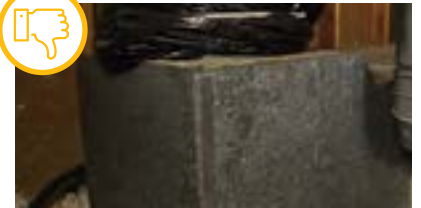
Ducto de pleno sobre cieloraso sin sellar.
