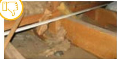
**Vigas del piso debajo de muro bajo (sin bloqueo con material rígido y sin sello).**
